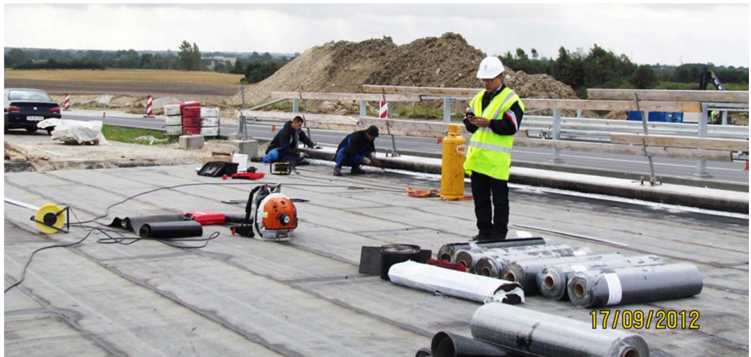
Vipperødvej Bridge (NIRAS 's Elverdam-Regstrup Project)
