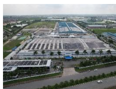
Dự án điện mặt trời áp mái nhà máy Gemtek - KCN Đồng Văn II, Hà Nam
