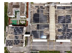
Điện mặt trời áp mái nhà máy Regina Hải Phòng
