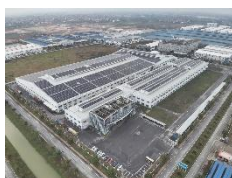
Dự án điện mặt trời áp mái nhà máy Bedra - KCN Hiệp Hòa, Bắc Giang
