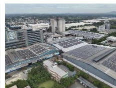
Dự án điện mặt trời áp mái nhà máy C.P - KCN Bàu Xéo, Đồng Nai
