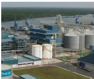
DỰ ÁN CẢI TIẾN NỒI HƠI VÀ LẮP MỚI HỆ THỐNG XỬ LÝ SOx - VAL (BUNGE VIETNAM)
