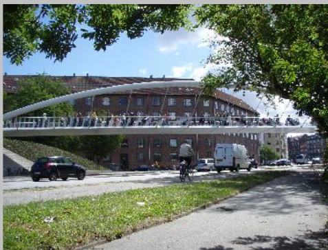
A BRIGDE IN DENMARK
